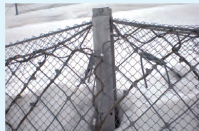
ひし形金網の変形状況 ( \phi 3.2 \times 50 \times 50 の変更により補強効果あり)
