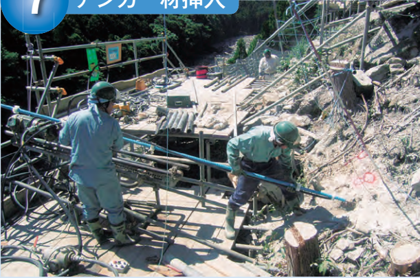
7 アンカー材挿入
