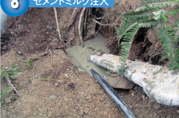
9 アンカー定着確認
